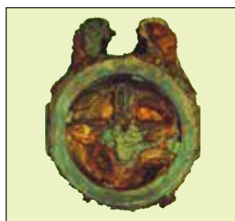
腐食した鑄鉄バルブのジスク
